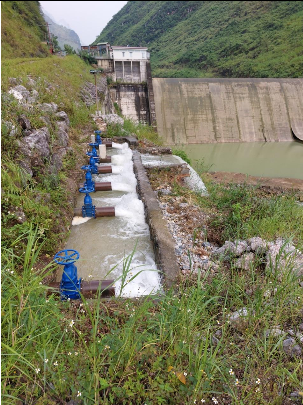
Hình 16. Công trình có 06 ống xả DCTT, nhưng chỉ lắp thiết bị đo lưu lượng tự động tại 01 ống xả DCTT
