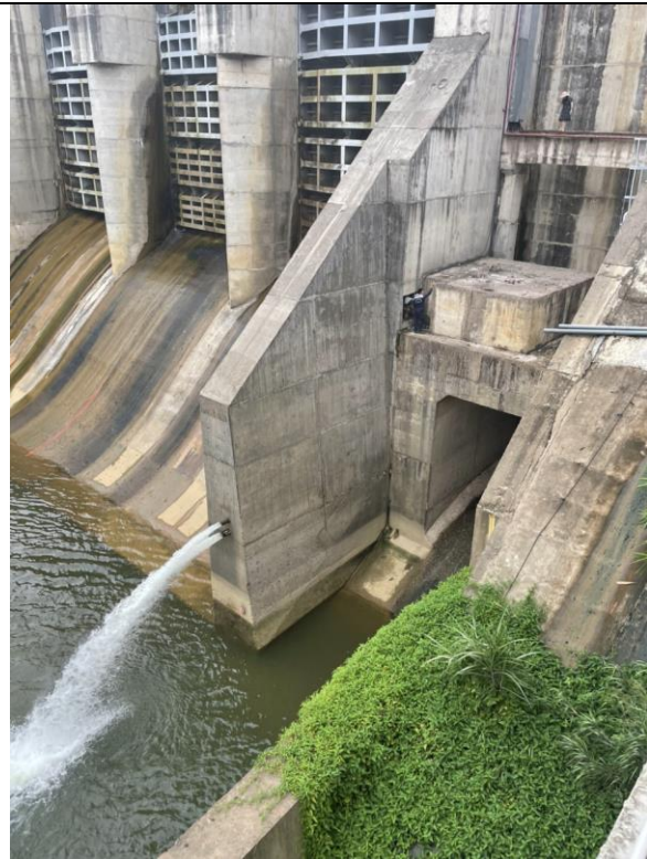
Hình 14. Biện pháp xả dòng chảy tối thiểu thực tế (02 đường ống đường kính 160 và 220mm) nhỏ hơn nhiều với hồ sơ đề nghị cấp phép (01 đường ống thép có đường kính 650mm)
